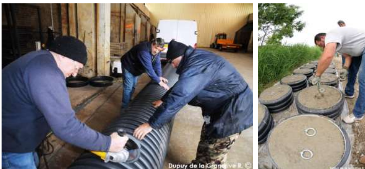
Figure 22: Fabrication des corps-morts par le service des plages.
