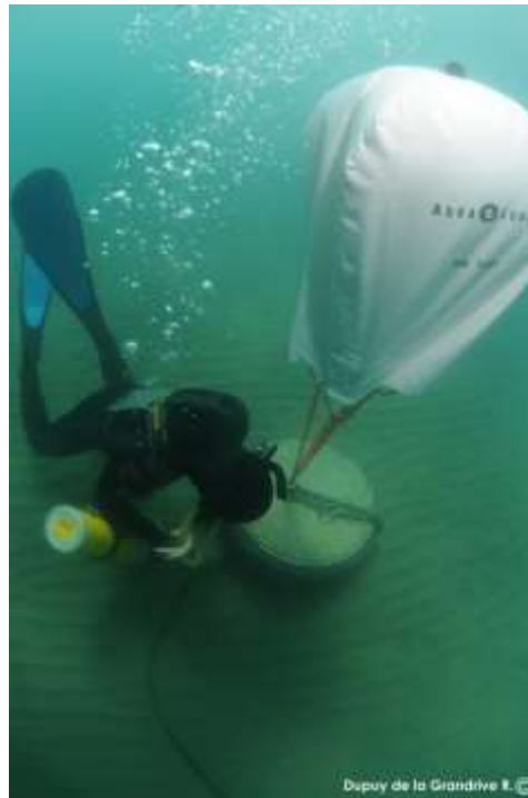
Figure 38: Déplacement d'un corps-mort à l'aide d'un parachute de levage.
